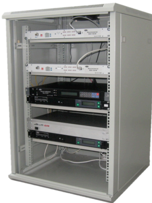
Стойка з модемом, мультиплексорами і устаткуванням живлення.
