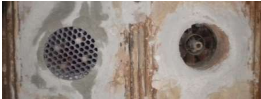
Фотознімок встановленого пальника трубчастого типу (зліва) поруч із штатним пальником
